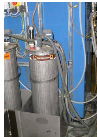
Kuvat 5,6,7. Isopropanolin varastosäiliö vuotoaltaassa, isopropanoliputki välisäiliölle sekä välisäiliö
