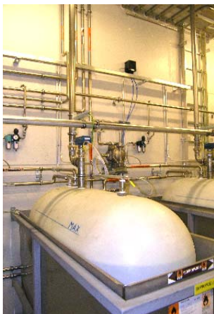
Kuvat 5,6,7. Isopropanolin varastosäiliö vuotoaltaassa, isopropanoliputki välisäiliölle sekä välisäiliö
